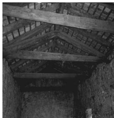
Sopra le lastre di pietra si notano ulteriori pietre che, aumentando il peso del tetto, servono a difendere i singoli elementi dalla bora.”
